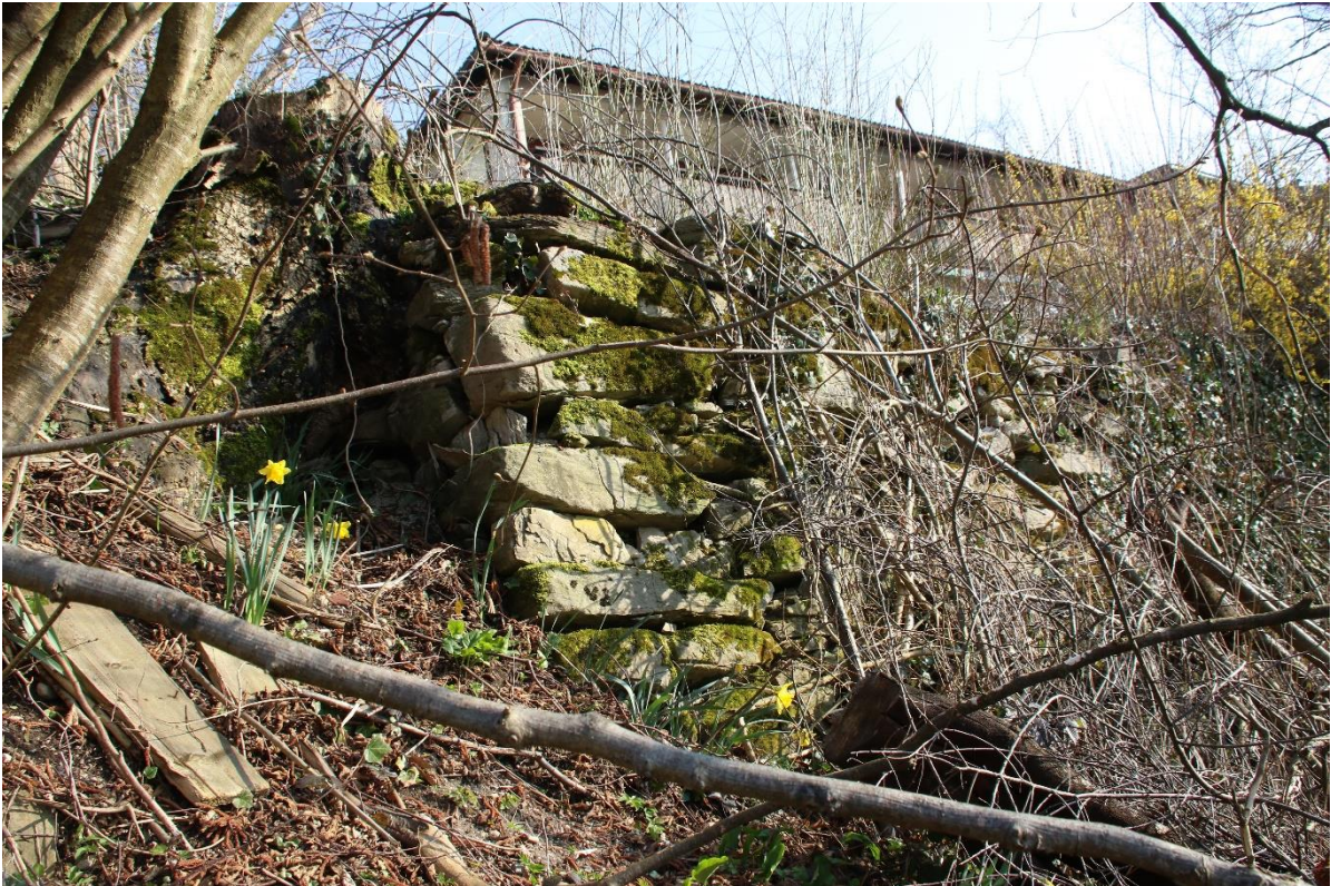
Abbildung 23: Stützmauer in dem südwestlichen Hangbereich des Plangebietes. 28.03.2020.
