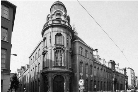
Leerstehendes ehem. Den Grooten Robijn 2007 | Quelle: onroerendergoed.be 2023
